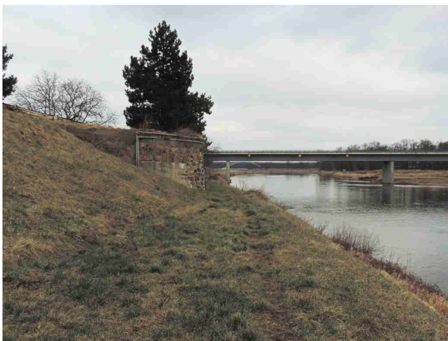
Dlažba z lomového kamene nasucho , stáří asi 90 let. Na dlažbě leží cca 30 cm tlustá vrstva jemnozrnného sedimentu (bylo ověřeno pedologickou sondou), který ji velmi účinně chrání před účinky velkých vod.
